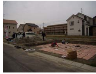
東中モデルハウス施工の様子
