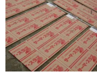
サーマ・スラブ施工写真
